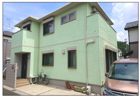
松戸市 T様 屋根 外壁塗装
