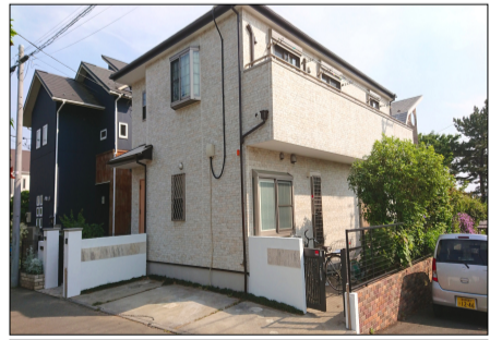
船橋市 Y様 屋根 外壁塗装
